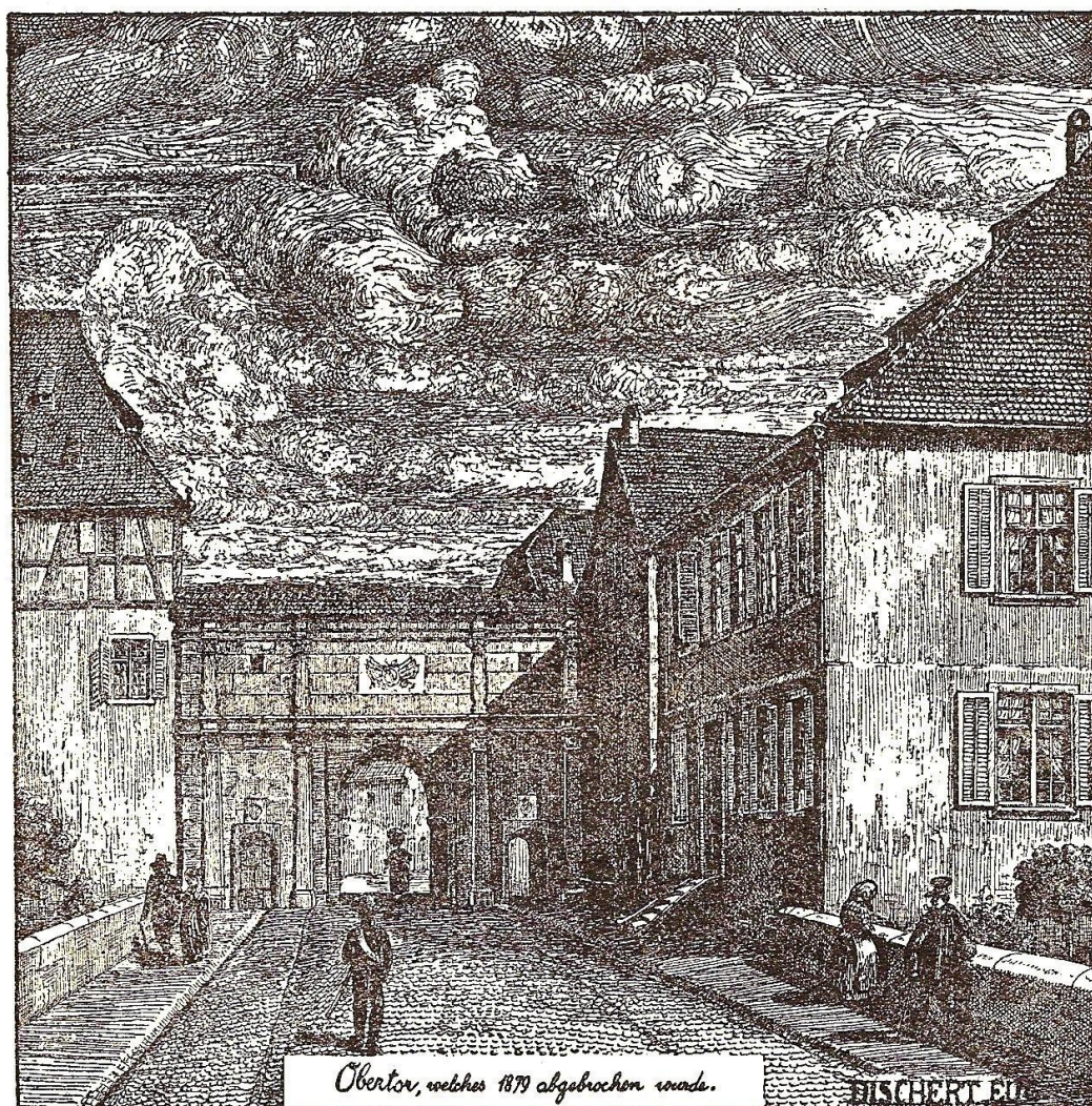
Porte haute qui a été démolie en 1879
